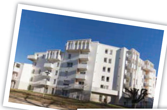
Réhabilitation de la Résidence Bovary
