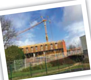
Chantier Les Frégates - Landouge
