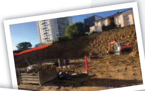
Chantier : Le Clos Fustel de Coulanges - rue Armand Dutreix
